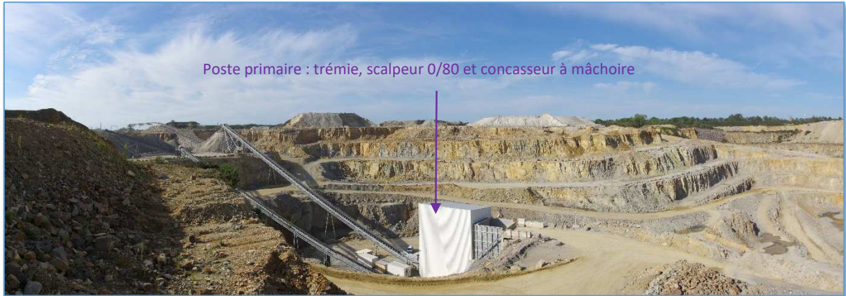
Fig. 6 : E – Vue sur le Sud de la fosse et sur le poste primaire
