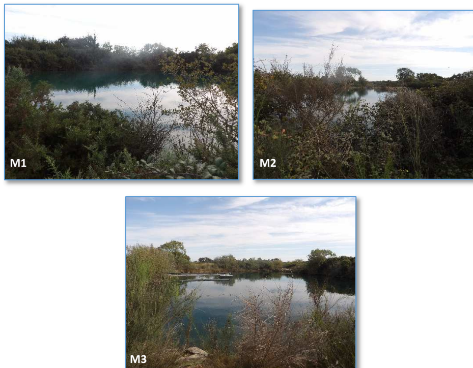
Fig. 12 : Vue sur les 3 bassins de décantation avant rejet R1
